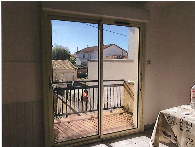
Une baie vitrée en aluminium équipée d'un volet roulant donnant sur un balcon recouvert d'un carrelage avec une rambarde métallique.
