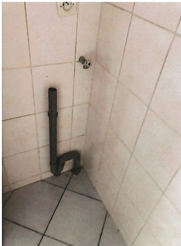
L'alimentation en eau et en électricité, l'évacuation pour une machine à laver.
