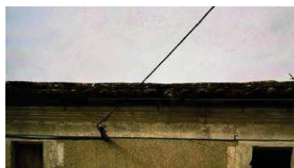
Couverture traditionnelle (tige de botte), présence de mousse et de lichen
