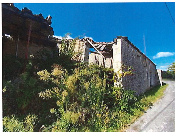
Photos n°5 Etat pilier d'angle en pied, auvent 1, démontrant l'instabilité structurelle au 30 09 22
