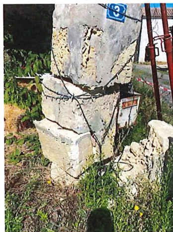
Photos n°5 Etat pilier d'angle en pied, auvent 1, démontrant l'instabilité structurelle au 30 09 22
