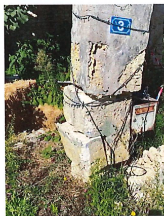
Photos n°5 Etat pilier d'angle en pied, auvent 1, démontrant l'instabilité structurelle au 30 09 22
