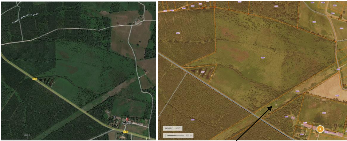
Ligne haute tension
