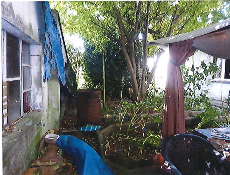
Les ouvertures sont anciennes, en bois simple vitrage.
