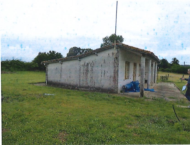
A l'extérieur, les murs sont crépis. La toiture est recouverte de tuiles.
