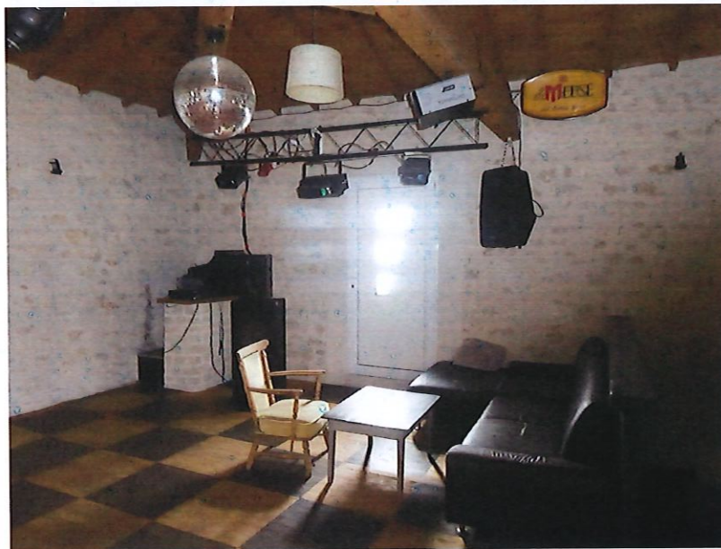
Plafond Des boiseries sur l'ensemble avec une poutraison apparente.
