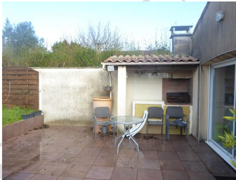
L'alimentation en gaz de la chaudière.
