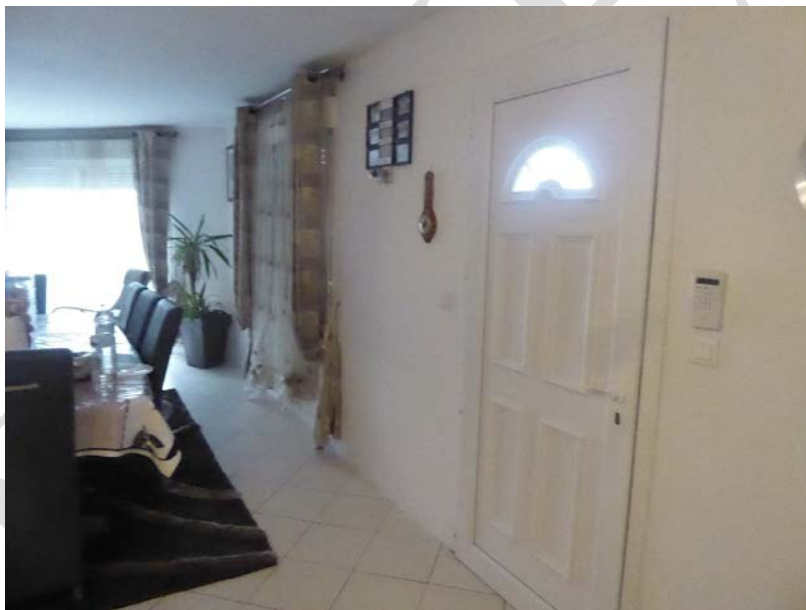
Une fenêtre en PVC équipée d'un volet électrique.
