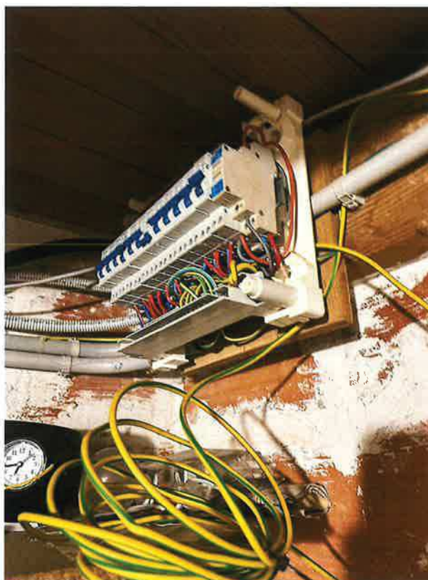
Depuis cette buanderie, au fond à gauche, j'accède à une cave.
